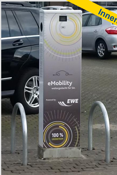
Wechselstrom Ladesäule 2 x 22kW mit Typ 2 Stecker
