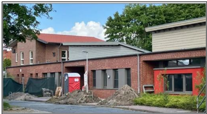
Abbildung 1: Kita-Gebäude, Am Rathaus 8, 27809 Lemwerder
