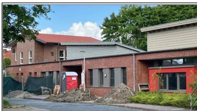
Abbildung 1: Kita-Gebäude, Am Rathaus 8, 27809 Lemwerder
