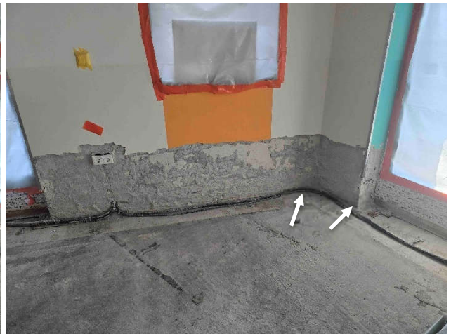
Abb. 3 + 4: Bewegungsraum – EG-13: Der Estrich wurde zurückgebaut und im unteren Wandbereich der Putz entfernt. Die Pfeile im rechten Bild markieren die Stellen, an denen Feuchtigkeit gemessen wurde (Abb. 5 + 6).
