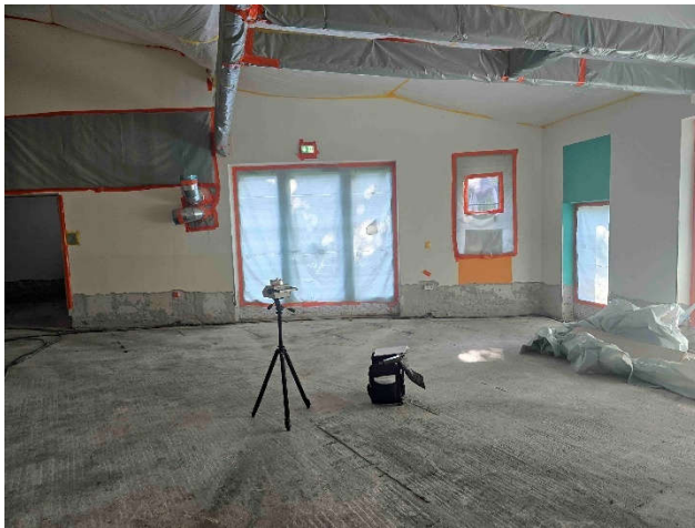
Abb. 3 + 4: Bewegungsraum – EG-13: Der Estrich wurde zurückgebaut und im unteren Wandbereich der Putz entfernt. Die Pfeile im rechten Bild markieren die Stellen, an denen Feuchtigkeit gemessen wurde (Abb. 5 + 6).
