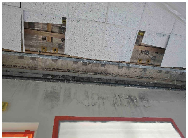
Abb. 17 + 18: Gruppenraum grün – EG-23: Aufgrund von fehlenden Dachpfannen kam es durch das Dach zum Wassereintrag. Einige Akustikplatten haben sich gelöst und an der Wand oberhalb des Fensters hat sich Schimmel gebildet.
