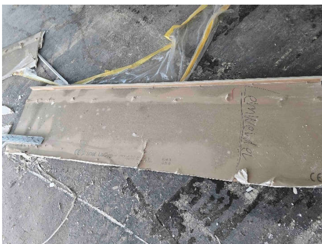
Abb. 19 + 20: Gruppenraum grün – EG-23: Die heruntergefallenen Akustikplatten sind stark verschimmelt (rechts im Detail).
