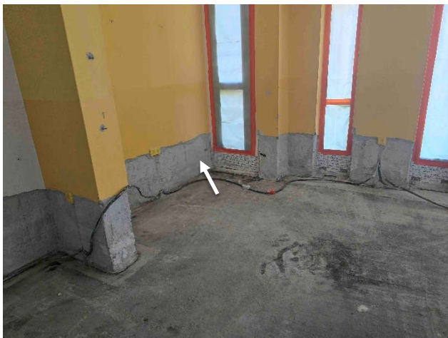
Abb. 11 + 12: Flur – EG-14: In der linken Ecke sind 131,7 digits messbar, d. h. die Wand ist noch feucht.
