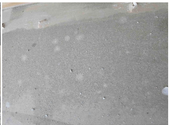
Abb. 19 + 20: Gruppenraum grün – EG-23: Die heruntergefallenen Akustikplatten sind stark verschimmelt (rechts im Detail).
