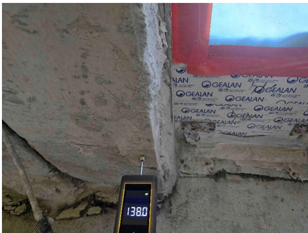
Abb. 13 + 14: Flur – EG-14: Die Werte schwanken von Wandabschnitt zu Wandabschnitt von sehr feucht bis leicht feucht (hier 138,0 und 89,2 digits).
